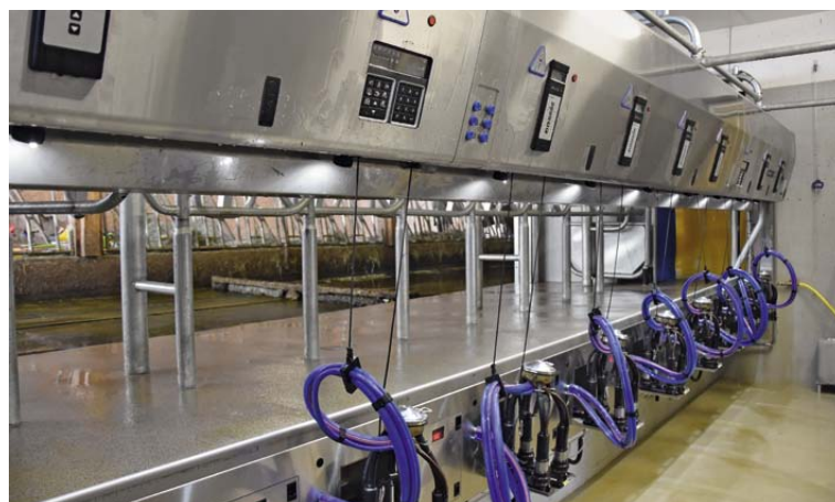
Le pilote de traite installé dans le coffret supérieur ainsi que le compteur à lait dans le coffret inférieur saisissent les données de traite.
