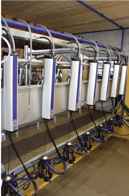
Salle de traite P2100: structure robuste, gouttière en inox et régulation de l'air comprimé pour une exploitation sans faille et durable.
