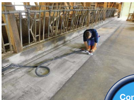
Fraisage du béton
