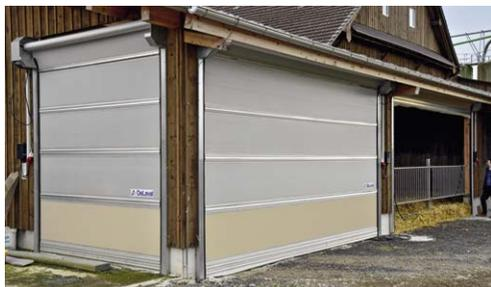
Les portes à enroulement transparentes laissent passer suffisamment de lumière dans l'aire de repos des veaux. L'aération et l'évacuation du fumier sont idéales. Et la commande peut être centralisée.
