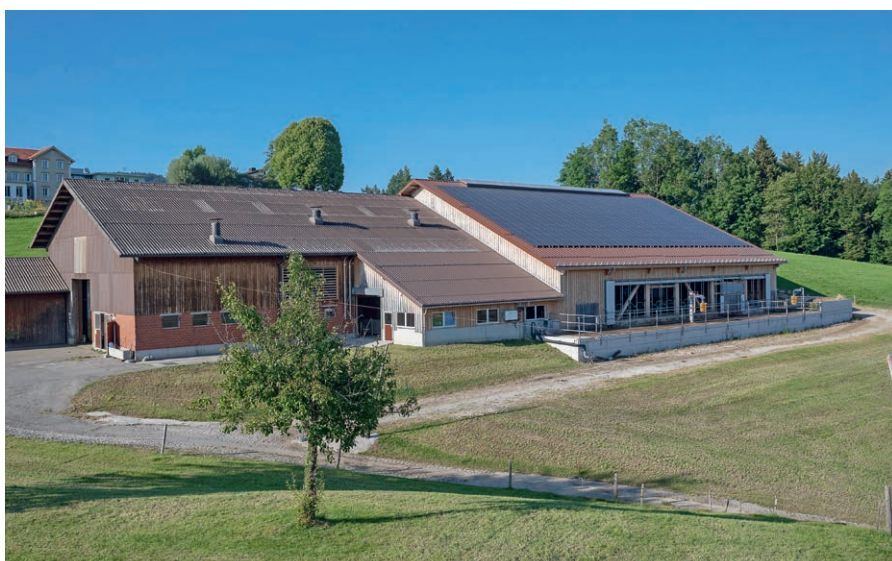
Une nouvelle construction est venue agrandir l'étable existante. La grande installation photovoltaïque (PV) complète idéalement l'exploitation automatisée. (Photo: Lorenz Reifler)
