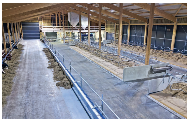
L'étable moderne, qui peut accueillir 137 bovins, est équipée de tapis en caoutchouc plein et de logettes surélevées.
