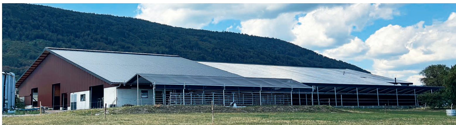
L'extension du bâtiment existant s'intègre parfaitement dans le paysage vaudois
